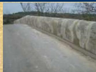
**-PONT SUR LE GOURGON CHEMIN DE LA VOIE** bétonnage de l'entrée et de la sortie du pont rehaussement de la partie centrale, nettoyage et empierrement des berges pour éviter l'érosion en cas de fortes pluies.
