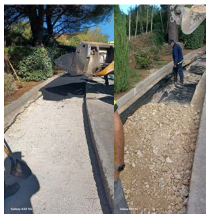
Route de Fons : Les racines des pins ont été découpées, mise en place d'une bâche afin d'éviter la repousse, installation d'un ralentisseur.
