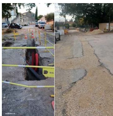
Rue du Can : Mise en discrétion terminée, Poteaux retirés A venir remise en état de la rue.
