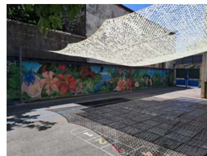
Mise en place des ombrières dans la cour de l'école
